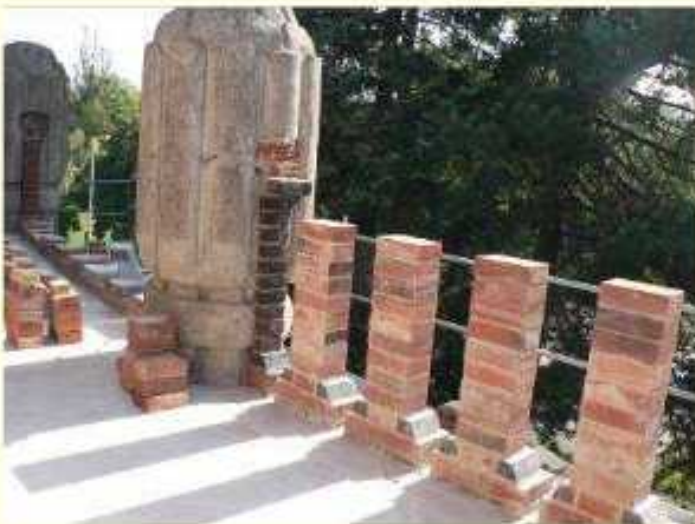
Obnova cihelného zábradlí balkonů.
