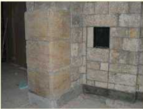
Restaurátorské práce na opukových stěnách v ateliéru.
